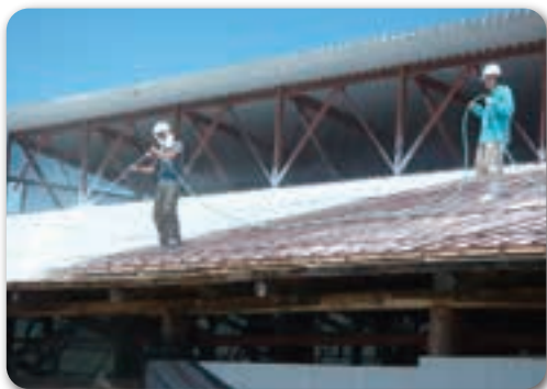
屋根の上でのドロマイト石灰乳塗布
