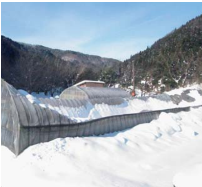
積雪によるハウスの倒壊
