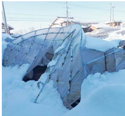
積雪によるハウスの倒壊
