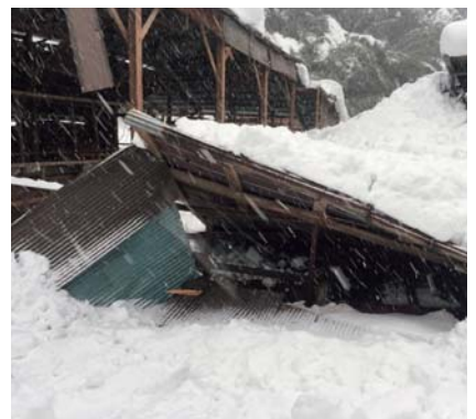
倒壊した畜舎
