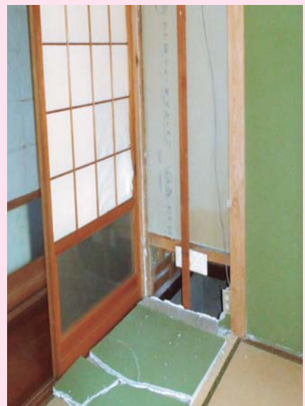
▲地震により、壁が落ちる。
