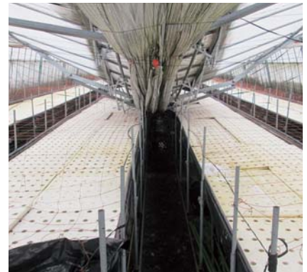
倒壊したハウス内
