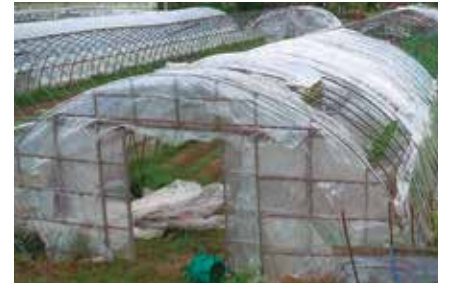
強風によりビニールが破れたハウス
