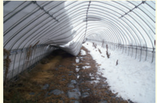
雪の重さで折れ曲がったパイプ
