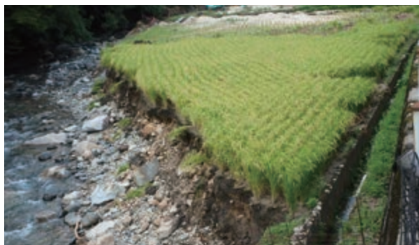
令和5年の台風7号による水田崩壊
